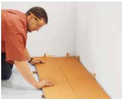
La pose du Marmoleum click est flottante et doit dès lors prévoir un écart d'au moins 10 mm par rapport aux murs, aux seuils, aux canalisations et autres obstacles afin de pouvoir compenser le travail du sol.
