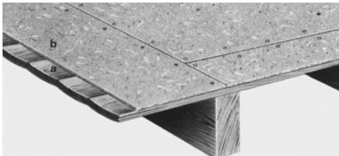
Utilisez des vis à tête noyée que vous alignerez face à face tous les 25 centimètres environ en prévoyant des vis supplémentaires au niveau des joints. Veillez bien à ne pas fermer totalement les joints entre les panneaux d'aggloméré. Ensuite, poncez soigneusement les joints. Les joints des panneaux d'aggloméré ont tendance à transparaître, si le matériau se met à travailler (gonfler). Ce phénomène est lié à la structure et à la qualité du matériau, mais aussi aux variations d'humidité relative.
